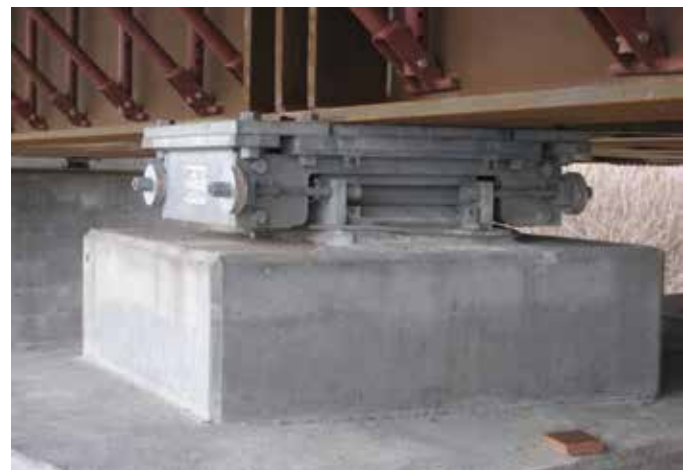
Figure 4 : Appui en élastomère fretté doté d'un noyau de plomb. À température ambiante, le plomb agit comme un solide élastoplastique et reprend sa forme initiale après une déformation
